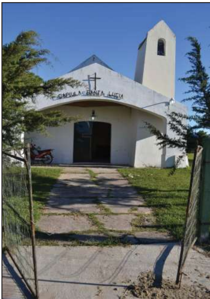
Fachada actual de la capilla.
